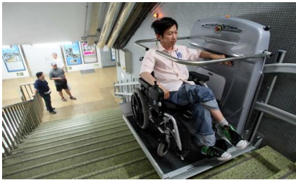
Gambar 3. Eskalator kursi roda untuk naik tangga atau turun tangga
