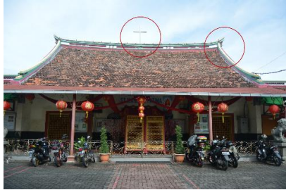
Gambar 1. Salib pada puncak atap dipasang sebagai identitas gereja dan ujung atap swallows tail merupakan khas bangunan Tionghoa
