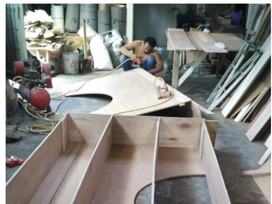
Gambar 16. Proses penyusunan rangka kayu pada elemen lantai
