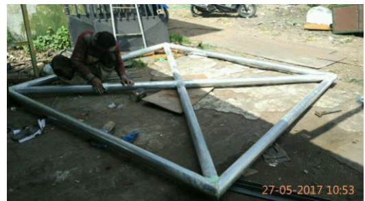
Gambar 17. Proses pengelasan rangka besi
