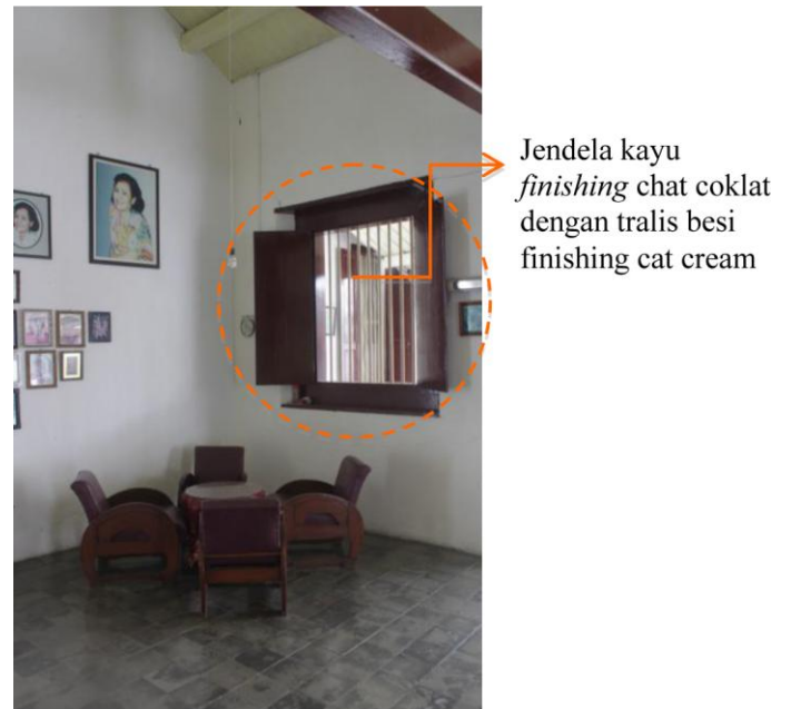
Gambar 21 : Jendela (Sumber : Dokumentasi Pribadi 2016)
