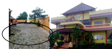
Gambar 17. Detail Lantai Vihara (Sumber : Dokumen Pribadi)
