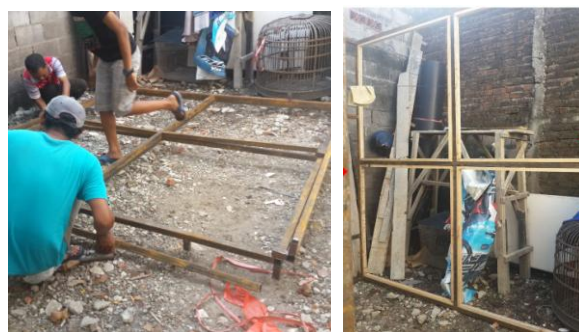
Gambar. 22. Perangkaian besi dan frame kayu.
