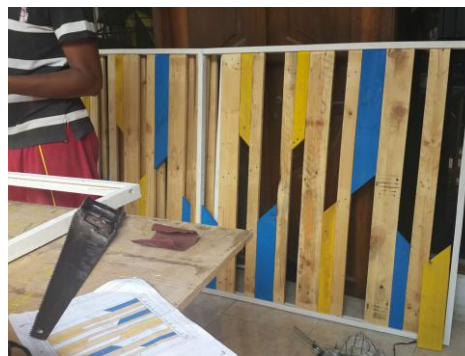
Gambar. 23. Pembuatan panel kayu dan pengecatan.
