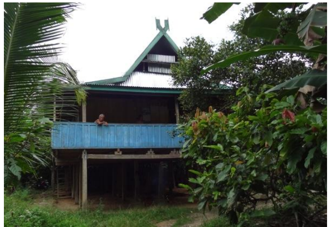
Gambar 21. Fasad Rumah Penduduk, suku Tolaki.
