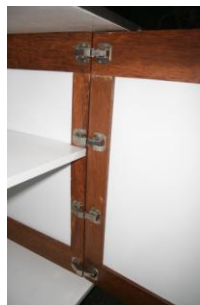
Gambar. 12. Island saat pintu terbuka, engsel yang digunakan sebanyak 4 buah dikarenakan kayu kelapa cukup berat, walaupun penerapan kayu tersebut hanya sebagai frame .
