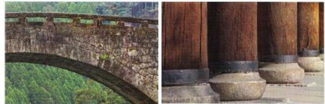
Gambar. 3. Penggunaan batu dalam arsitektur Jepang, sebagai struktur jembatan (kiri) dan pondasi bawah kolom (kanan).
