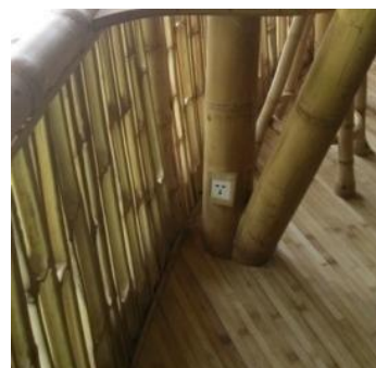
Gambar 4 Railing Pada Area Tengah
