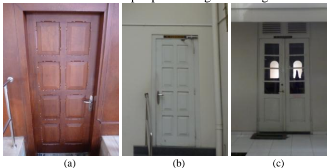
Gambar. 14. (a) Pintu ruang Sakristi yang diakses dari panti imam (b) Pintu ruang Sakristi yang diakses dari depan (c) Pintu ruang Sakristi yang diakses dari belakang
