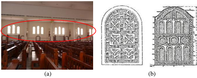
Gambar. 10. (a) Bentuk jendela di sepanjang dinding panti umat (b) Jendela gaya Early Christian dengan bentukkan pelengkung pada bagian ambangnya (Sumber: Fletcher 1928,p.217)
