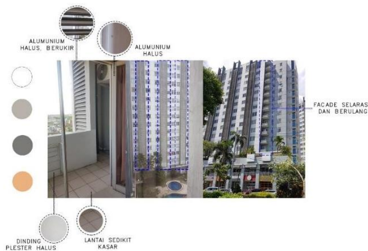
Gambar 7. Warna, tekstur dan keteraturan facade Apartemen Metropolis (Sumber: penulis)
