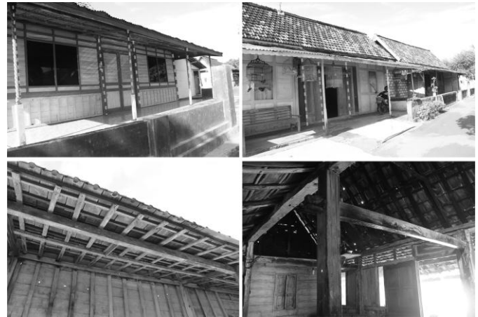
Gambar 2.15 Elemen Struktur Sebagai Artikulasi Sumber : Dokumentasi Pribadi
